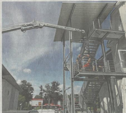
Nach dem Hochwasser: Ein Kran hievt schwere Rollstühle in der Villa Dominik nach unten. MARIE ELLEN KRAUSE/VKM MENDEN
